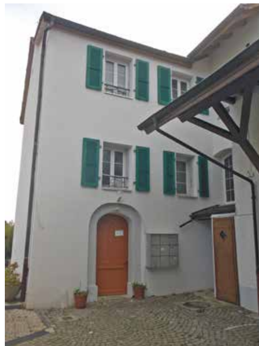
La tour du côté sud. (BDP)
