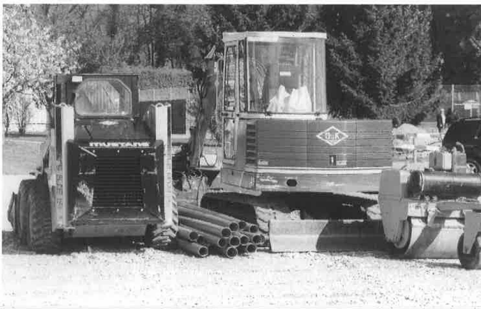
Après quelques jour: le revêtement prend l'allure de nos futurs terrains
