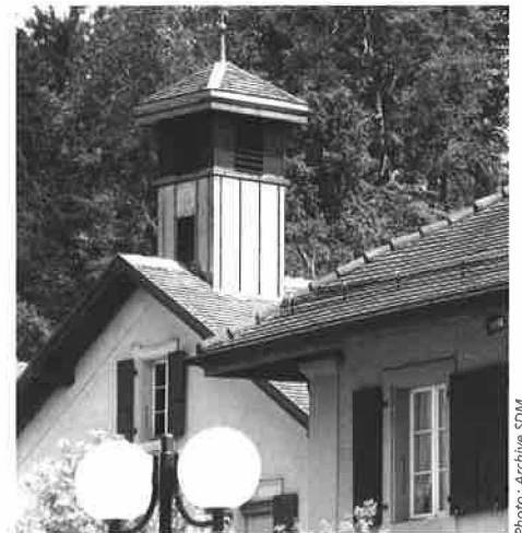
Construction du clocher sur le Collège du Petit-Mont, à l'occasion du 50 e anniversaire de la SDM
