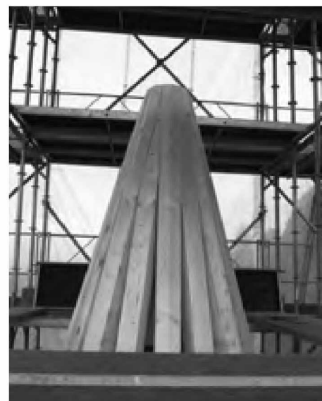
Charpente du clocher après restauration
