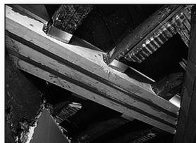
Deux poutres armées ont été mises en place afin de renforcer la structure existante entre les étages
