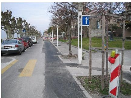
Le projet d'éclairage du Quai Perdonnet s'est poursuivi cette année. Les travaux ont été effectués, en ce qui concerne le génie civil, simultanément avec d'autres services industriels. Le type de matériel d'éclairage utilisé correspond à celui des étapes de 1994 et de 2001 ; il est optimal en matière énergétique (70 W/source)
