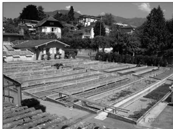
Centre horticole avant rénovation
