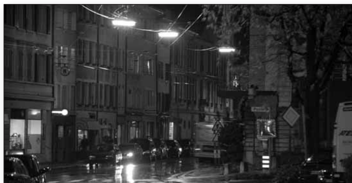
EP rue d'Italie avant renouvellement
