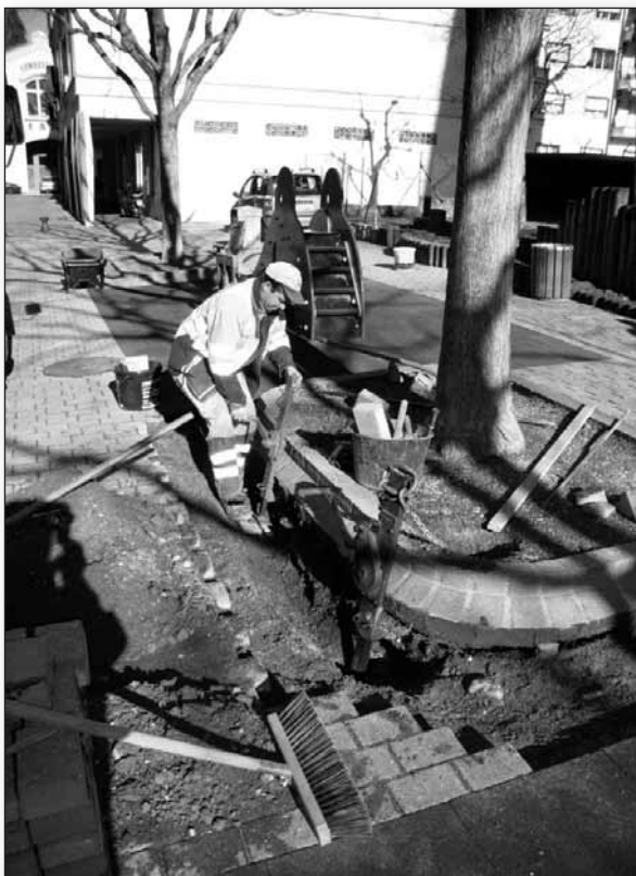
Rue de la Byronne , réfection place de jeux
