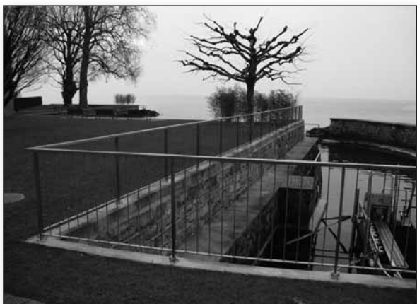
Nouvelle barrière Promenade Eiffel
