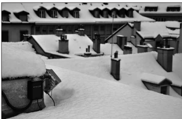
La neige accumulée devant l'antenne sur le toit du bâtiment du feu
