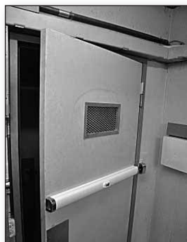
La porte du local téléphonique avec la barre de renforcement.
