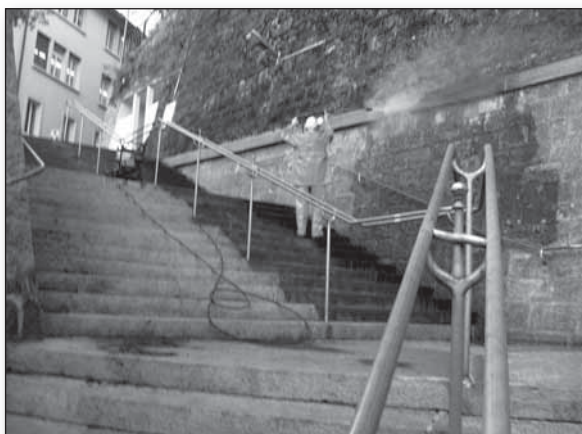
Passage des Bosquets : nettoyage des murs
