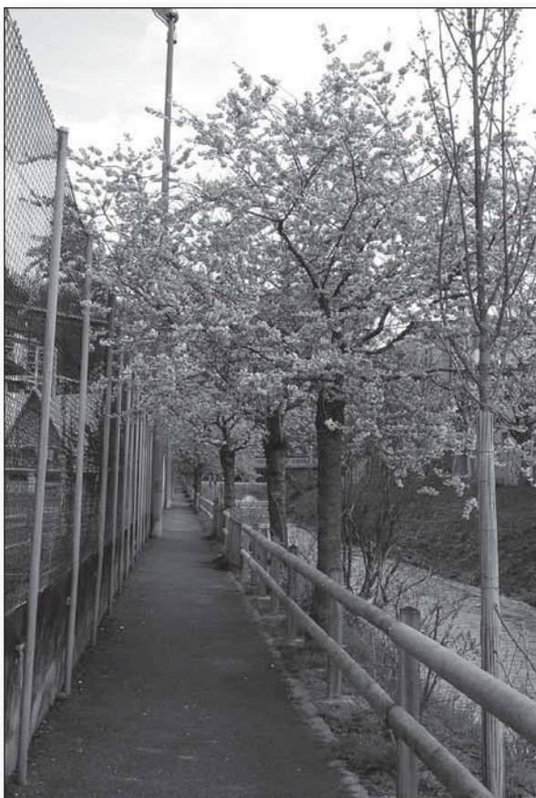
Sentier Copet III : pose de barrières
