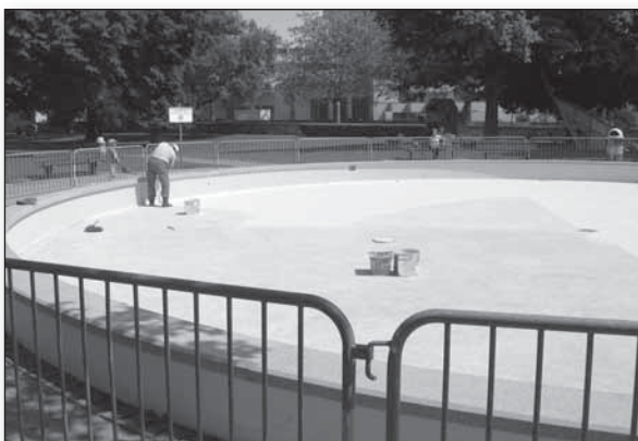
Pataugeoire : réfection avec peinture à l'eau
