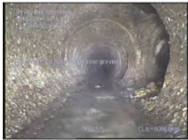
15-15-44, 00:02:30, 0,80m Raccordement buriné à 3 h. / avec graviers
