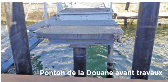
Ponton de la Douane avant travaux
