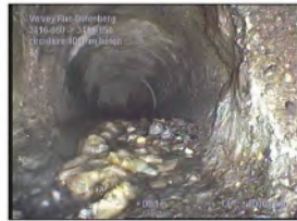
15-15-49, 00:02:30, 0,80m Raccordement buriné à 3 h. / avec graviers
