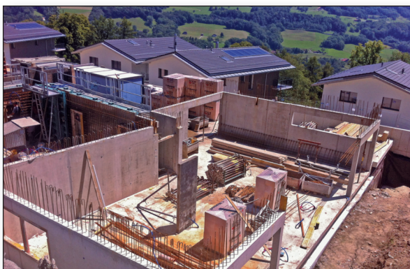
Une nouvelle garderie sort de terre...
