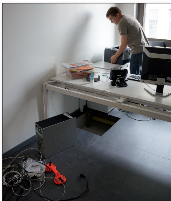
Branchement et remise en route des équipements informatiques du CSI avec les câbles à raccorder sous le plancher suspendu.
