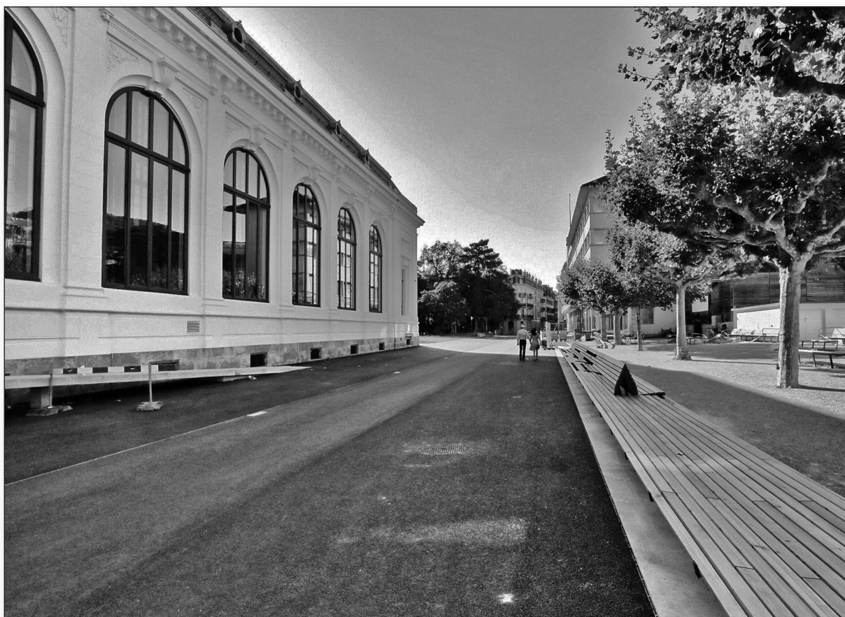
Septembre 2014 : les travaux de la rue Louis-Meyer Est sont en phase terminale
