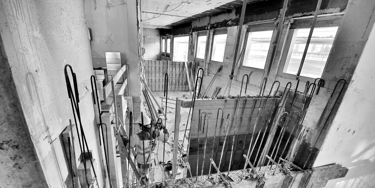
le bâtiment de l'ex-EPA en chantier
