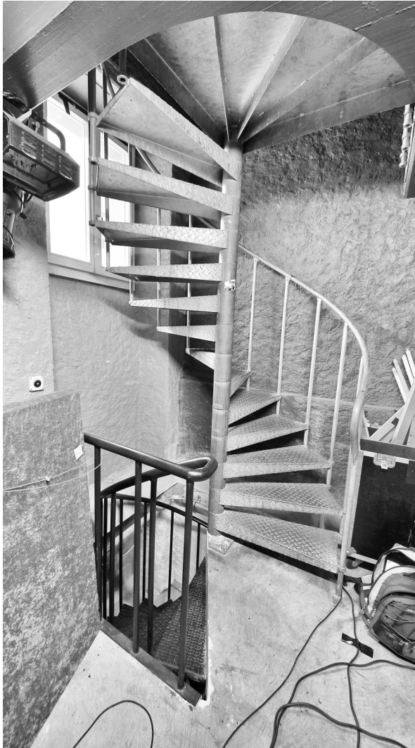
les nouveaux escaliers du RKC
