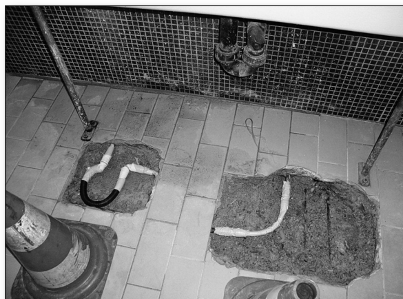
WC publics réparation tuyauterie
