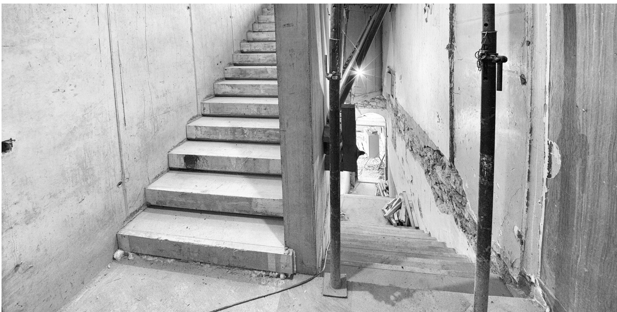
la salle de répétition et les escaliers
