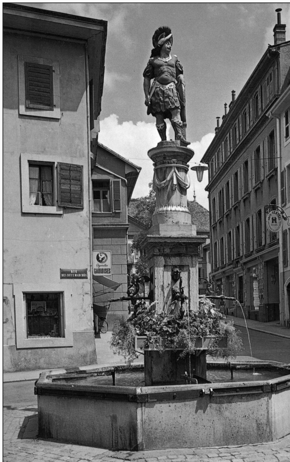
Fontaine du Guerrier : avant le début des travaux
