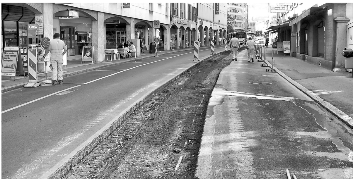
La mise en œuvre du nouveau revêtement et les travaux d'entretien à la rue de Lausanne
