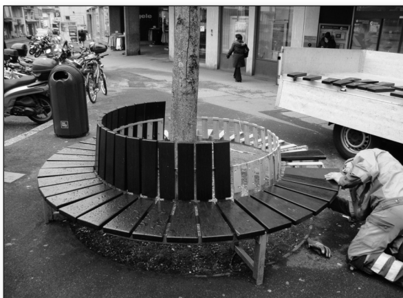
Banc en réfection à la rue de Lausanne
