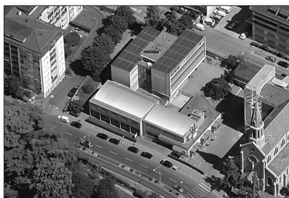
Panneaux solaires, école de la Part-Dieu
