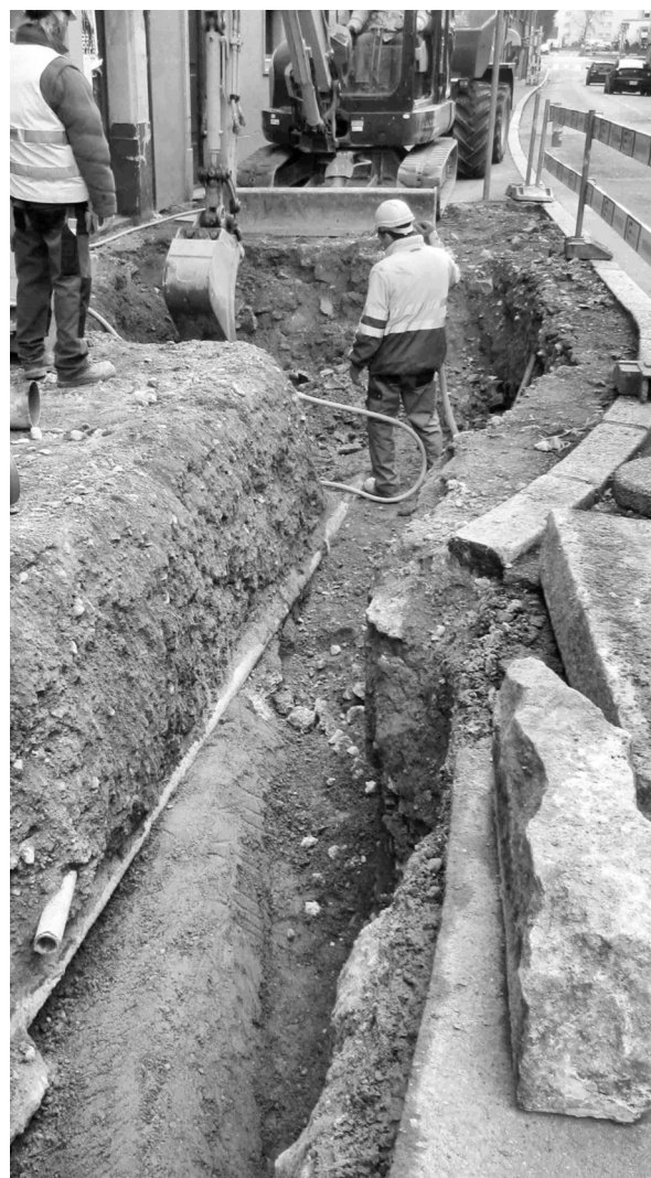
remplacement des collecteurs devant l'Oriental
