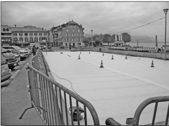
Espace Plage en cours d'installation
