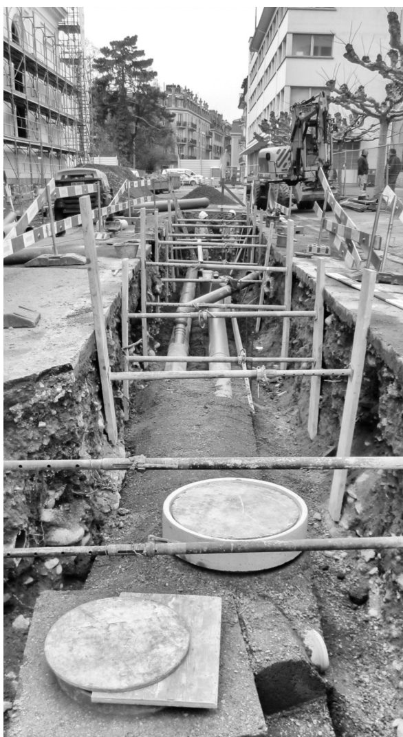
la pose des nouveaux collecteurs dans le secteur Louis-Meyer Est
