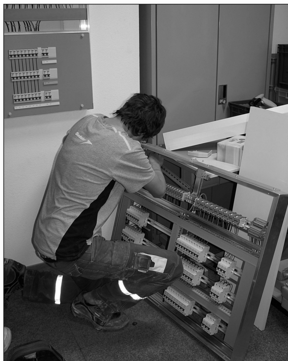
Remplacement du tableau électrique
