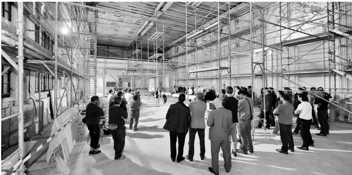
discours lors du sapin de chantier à la Salle del Castillo
