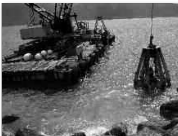
Le relevage d'enrochements
