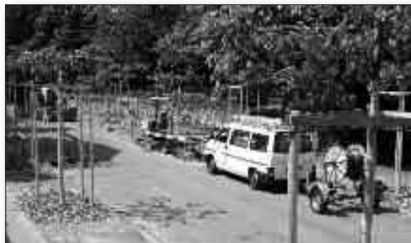
Le chantier du boulevard de Saint-Martin
