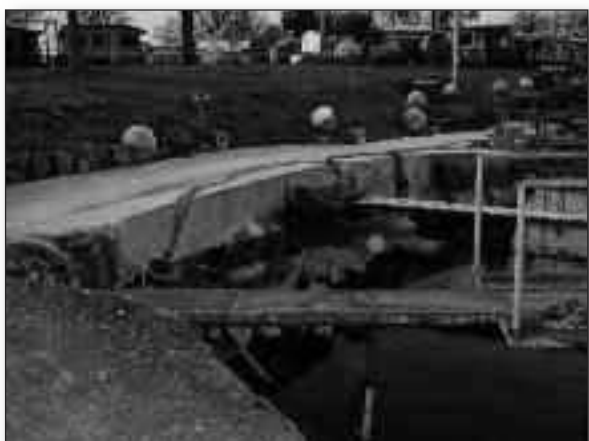
Réfection accès port de la Pichette
