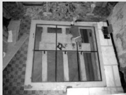
Trémie pour éclairage zénithal dans coursiive
