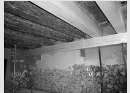
Renforcement poutraison caveau
