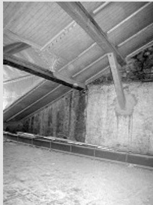
Renforcement de la charpente
