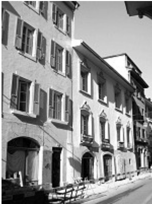
Façades restaurées rue des 2 Marchés
