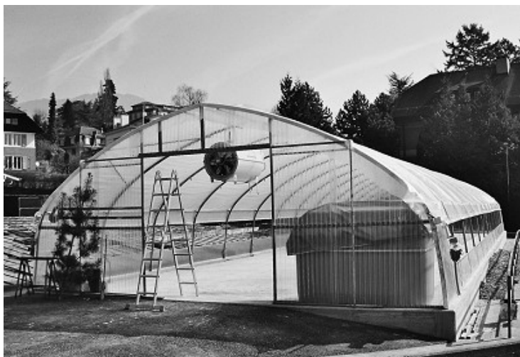
Nouveau tunnel de culture mis en place en janvier 2003
