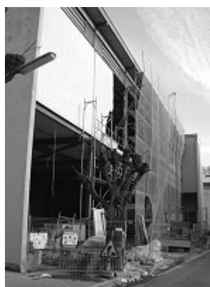
Démolition façade Sud
