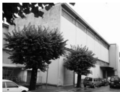
Façade Sud avant travaux
