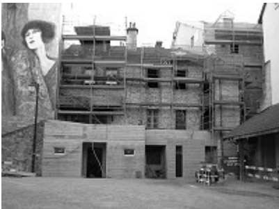
Réfection des façades pl. Scanavin
