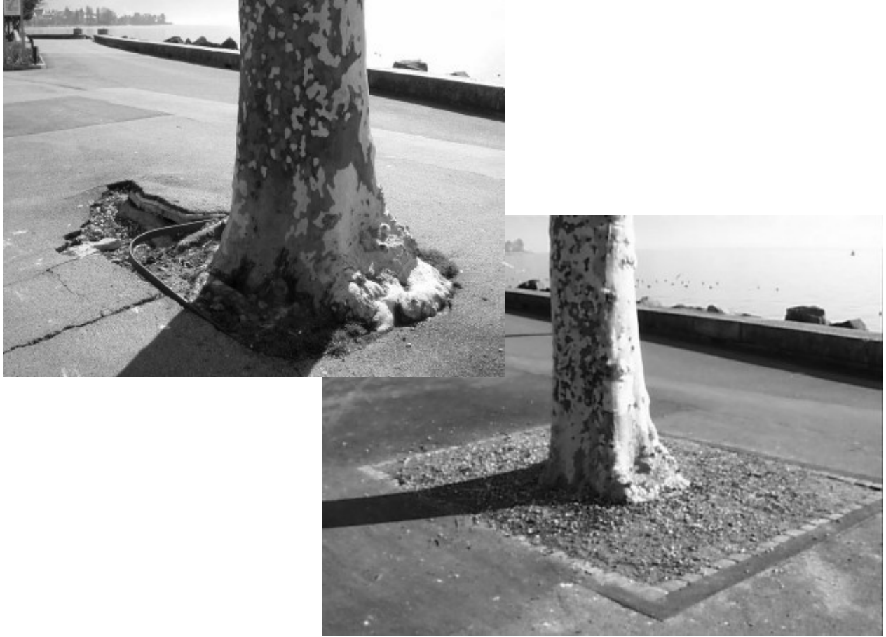
Entourage d'un arbre au Quai Perdonnet avant et après travaux
