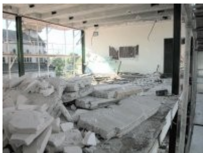
19 juillet 2002 - Travaux de démolition
