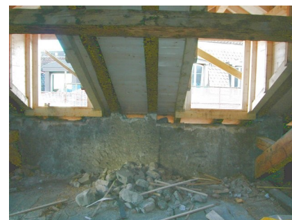
Création de lucarne dans le comble
