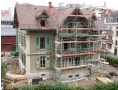
6 août 2002 - démolition terminée, début des travaux en façades
