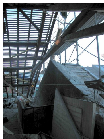
Réfection du pignon ouest
