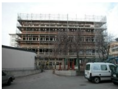
10 décembre 2002 - Pose des nouvelles fenêtres
