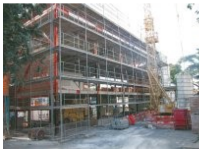
30 août 2002 - Travaux de reconstruction
