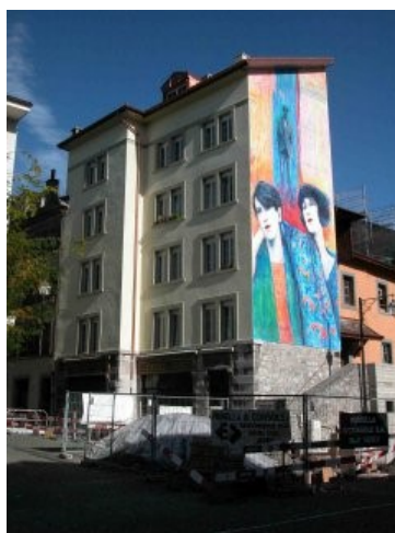
Façade et toiture rénovée
