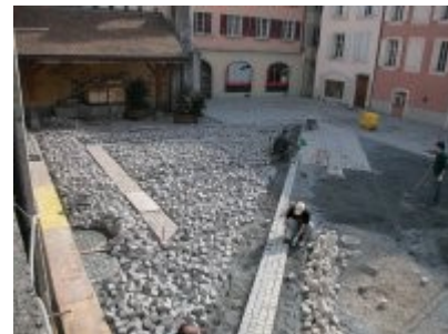
Travaux de pavage zone est
