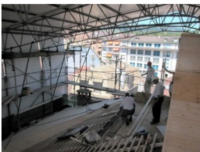
Travaux de couverture
