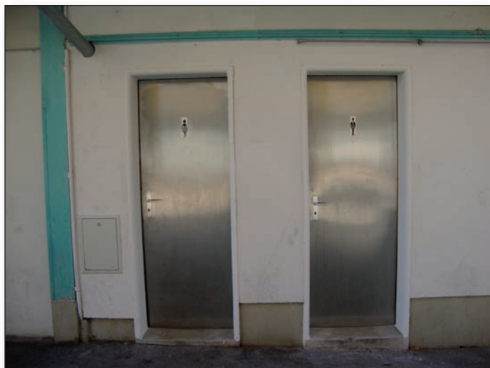
WC Place Robin, portes en inox
