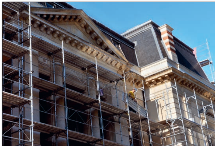
Chantier du musée (vue façade ext. / vue intérieure avec machines de chantier).
