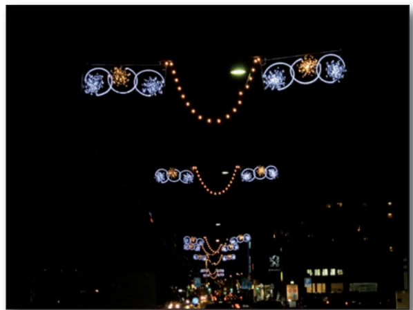
Nouvelle illumination av. du Général-Guisan
